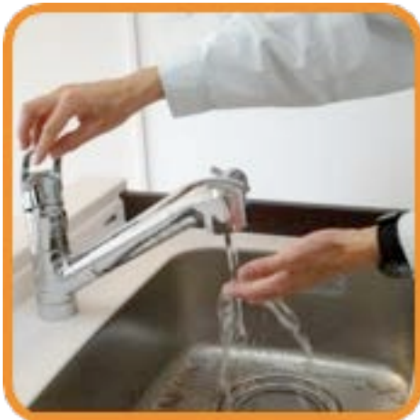
給湯の吐水確認
