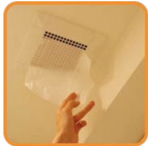
トイレ換気扇の動作確認
