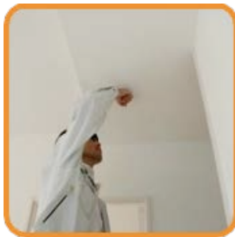
天井下地の強度確認
