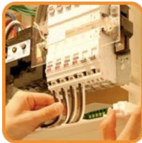
電線と機器端子の確認
