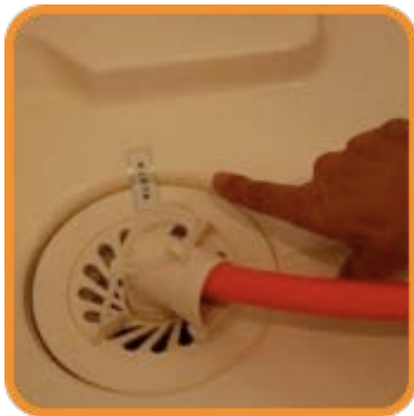
洗濯パンの溢れ確認 (1)
