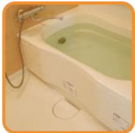
浴室の溢れ確認
