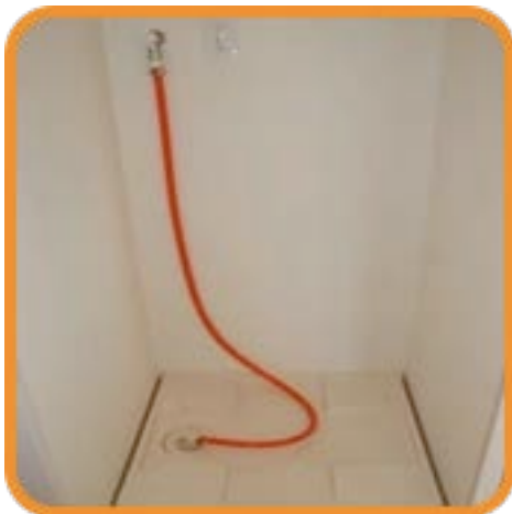
洗濯パンの溢れ確認 (2)
