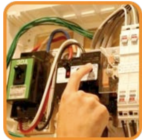
漏電ブレーカーのテスト
